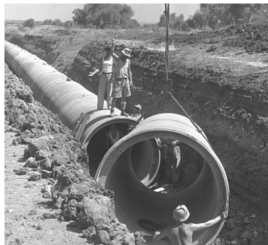
הנחת צינורות למוביל המים הארצי (מתוך אתר חברת "מקורות")
