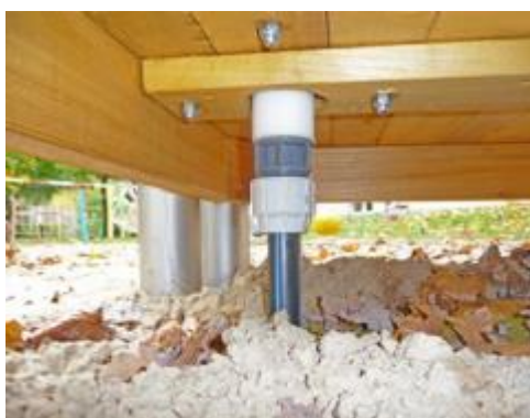
חיבור לצינור לחץ ולא למאגר, דוגמא: חיבור משאבת Spielbauס יבוא חב' גנית פארק
