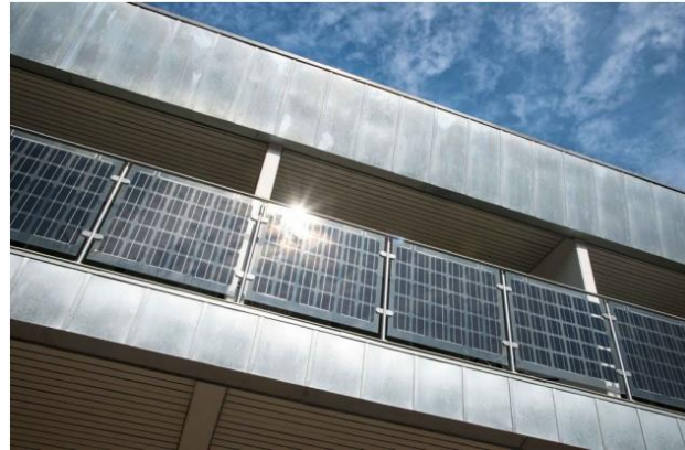
تم دمج الألواح الشمسية المزودة بتقنية BIPV كدرايزين في أحد الفنادق في هولندا بإذن من إسرائيل BIPV و Solarinnova
