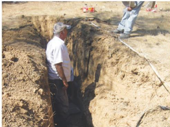
איור 2 תעלה שנחפרה לעריכת סקר הקרקע
