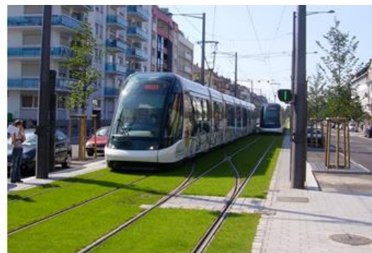
תוואי מסילת הרק"ל צבוע ומובחן מהדרך, משמאל: מעבר חציה ייעודי להולכי רגל (מקור: Strasbourg Eurométropole)
