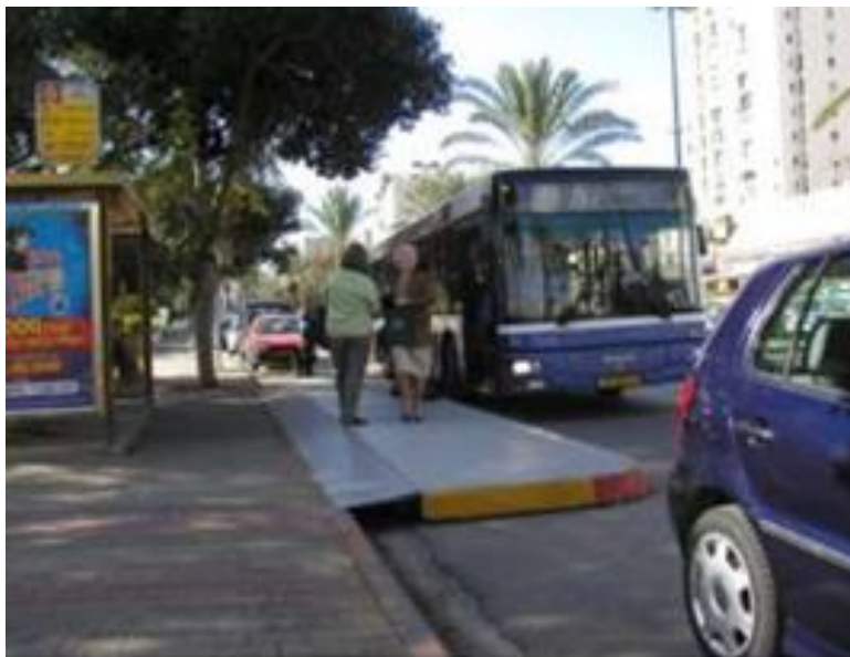
תחנת אוטובוס באנטי-מפרץ - מפנה את מרחב המדרכה לתנועת הולכי הרגל ומעודדת בטיחות לעולים עם עגלות (מתוך: קווים מנחים לתכנון תחנות אוטובוס נגישות, נגישות ישראל)
