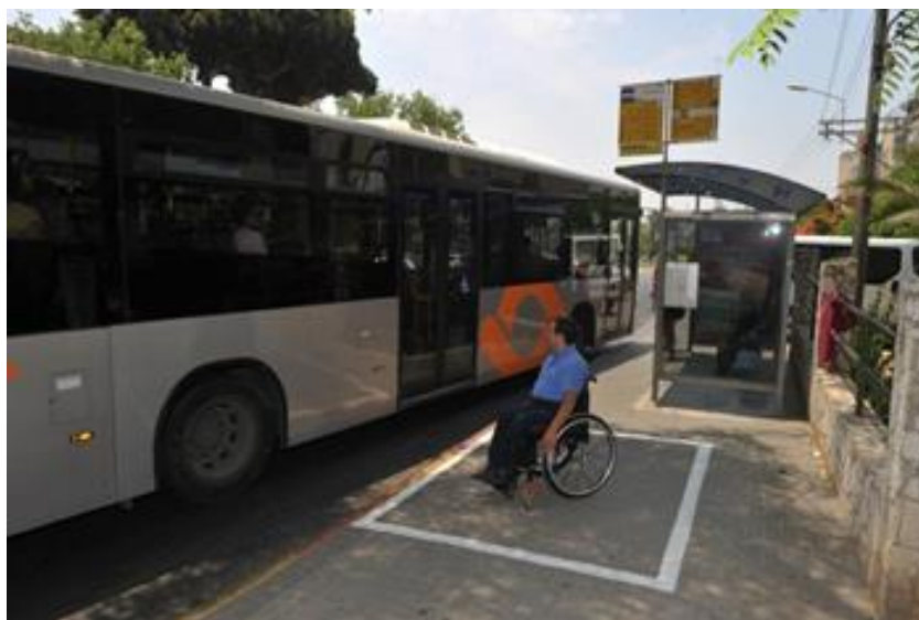
משטח היערכות המאפשר עליה נוחה ובטוחה עם כסא גלגלים, ועגלת ילד (מקור: מחלקת הנגישות, עיריית הרצליה)
