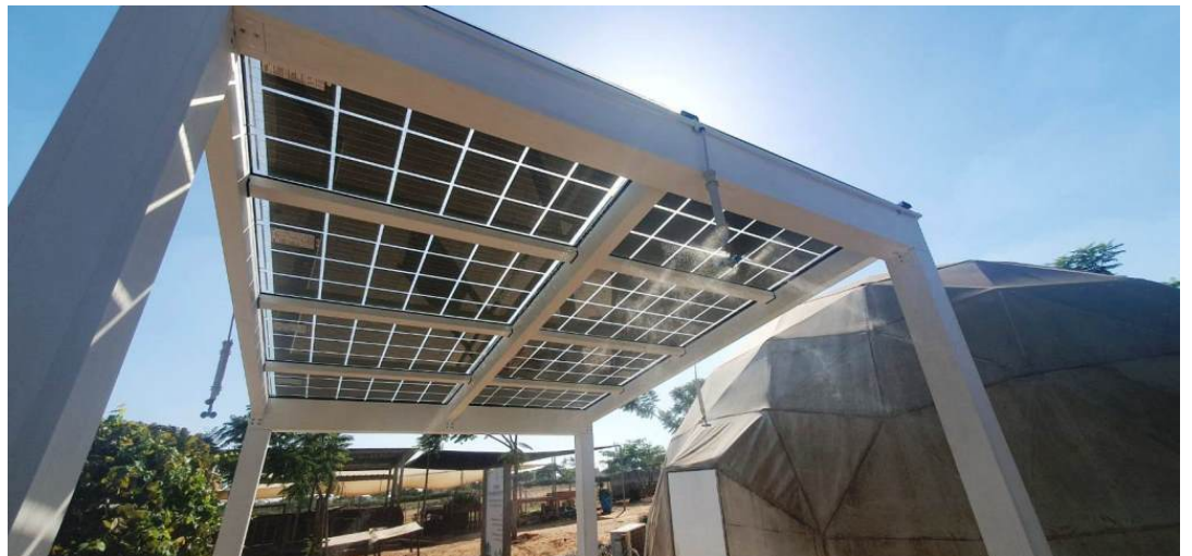
סככה סולרית, שהוקמה במשתלה טיפולית של עיריית כפר סבא, בשיתוף פעולה עם אוניברסיטת תל אביב ובמימון האיחוד האירופי. לצילי הסככה הותקנה מערכת מתזים, הפועלת באמצעות החשמל הסולרי ומייצרת 'ערפל' לטובת קירור סביבת הסככה | באדיבות חברת BIPV Israel ו-Solarinnova
