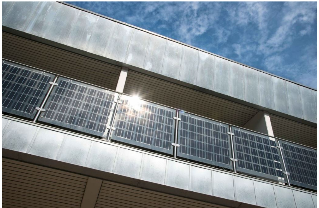
פאנלים סולריים בטכנולוגיית BIPV משולבים כמעקה במלון בהולנד | באדיבות חברת Solarinnova ו-BIPV Israel
