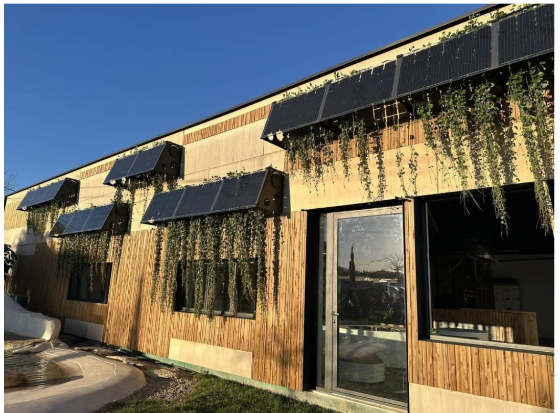
אדניות סולריות וקירות מחופים צמחייה המסייעים בבידוד המבנה. מבנה משרדים בברצלונה | באדיבות חברת BIPV Israel - Solarinnova
