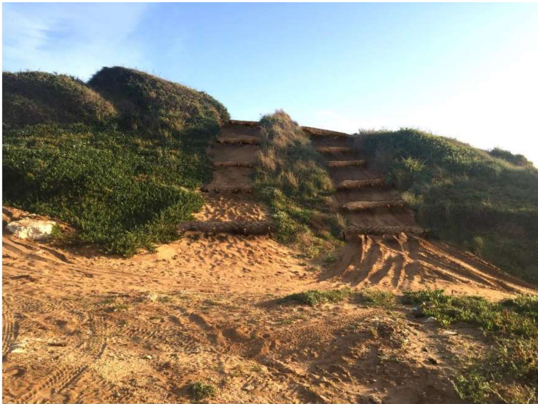
תמונה 43/הדמיה - ייצוב ראשוני של הקרקע באמצעות גלילי קוקוס ורשתות (סטודיו אורבנוף)
