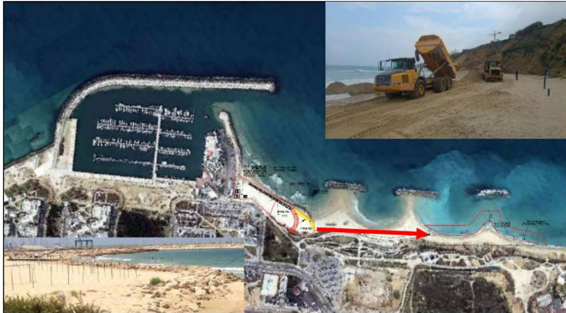
איור 3.2. העברת חול מהמרינה לשובר הצפוני. חול שנצבר בכניסה למרינה, נשאב והועבר לאחסון על החוף. בפברואר 2016, כ- 11,000 מ"ק חול הועברו בשינוע יבשתי מהכניסה למרינה לחוף מול השובר הצפוני.
