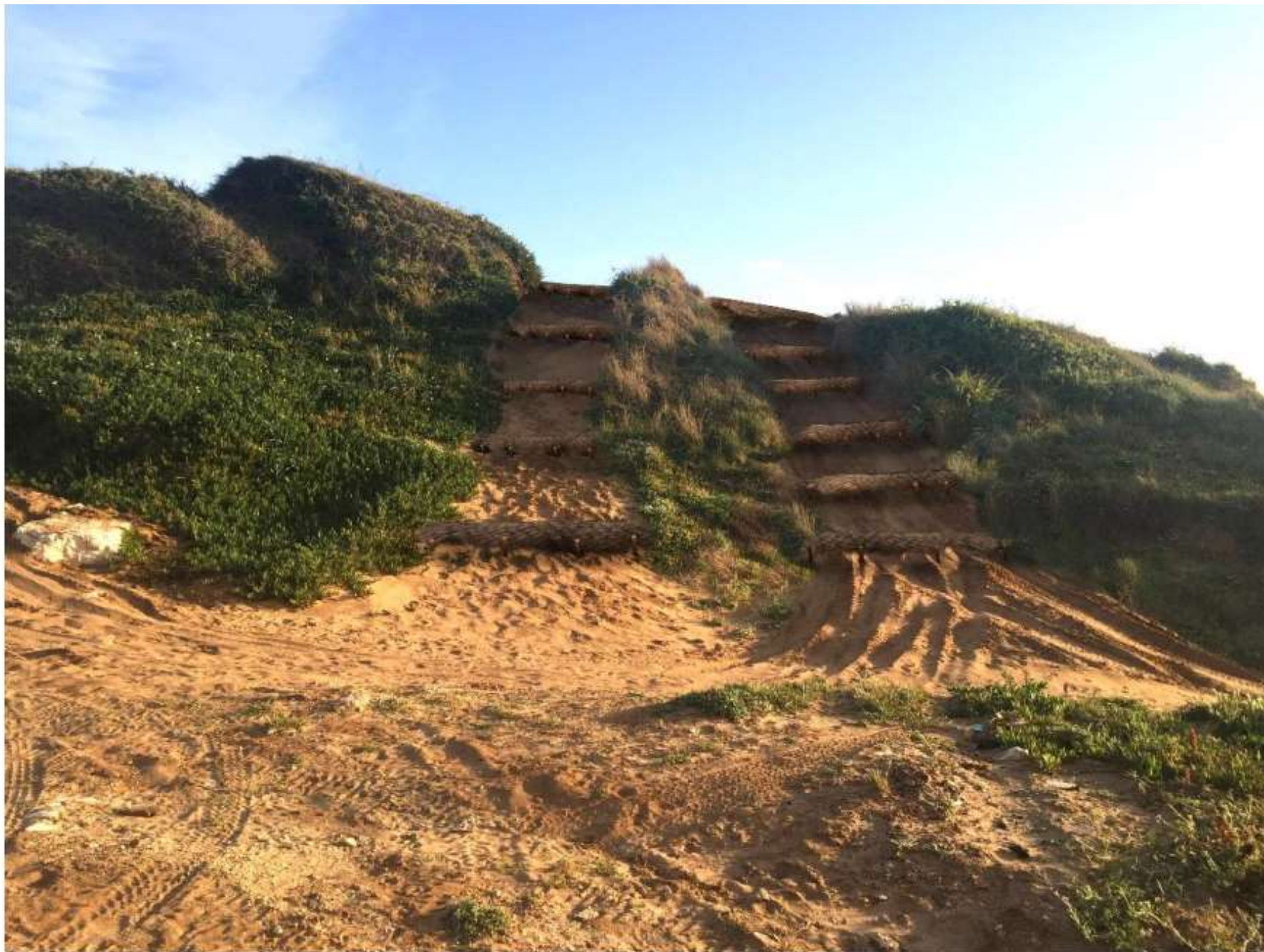
תמונה 43 והדמיה - ייצוב ראשוני של הקרקע באמצעות גילי קוקוס ורשתות (סטודיו אורבנוף)
