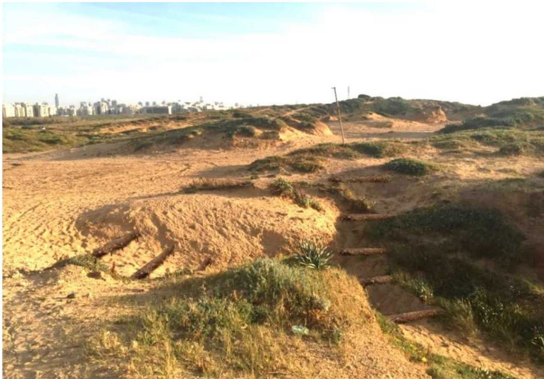
תמונה 46 / הדמיה - ייצוב ראשוני של הקרקע בפתח הוואדיות באמצעות גילי קוקוס ורשתות (סטודיו אורבנוף)
