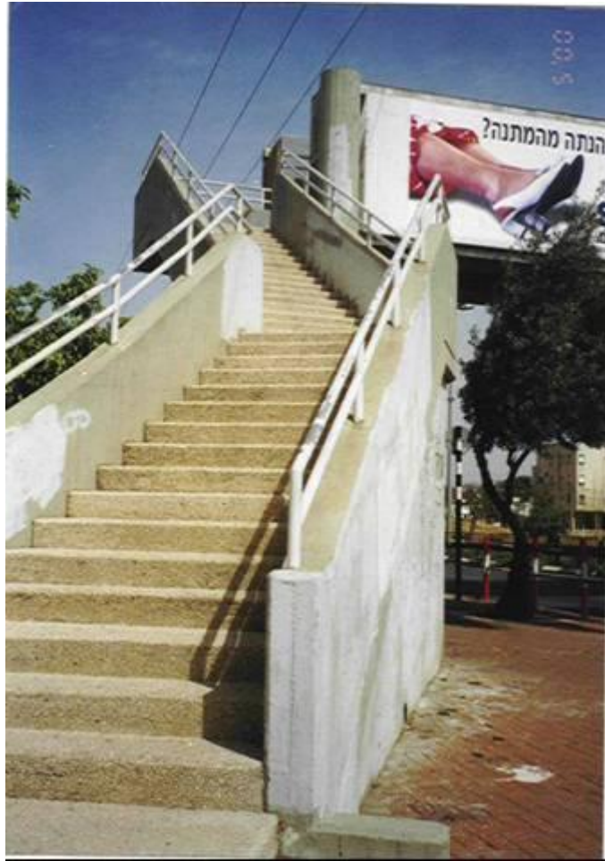
איור 45. מדרגות במעבר עילי: למטיבי לכת בלבד!
