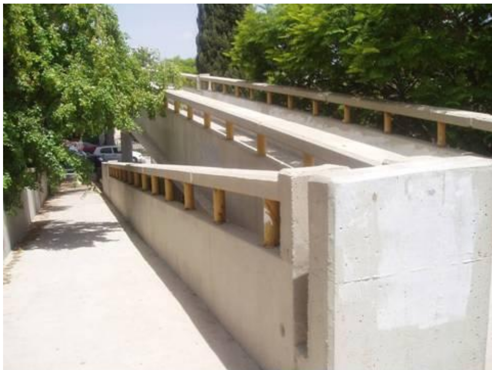
איור 50. כבש העלייה בשיפוע מתון למעבר עילי בחולון
