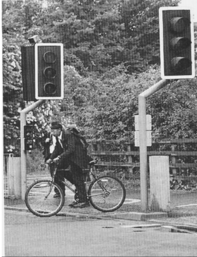
איור 39. מעבר חצייה עם גלאי תת-אדום לזיהוי הולכי רגל (ווארויק, אנגליה). (מקור: TRL 1997)
