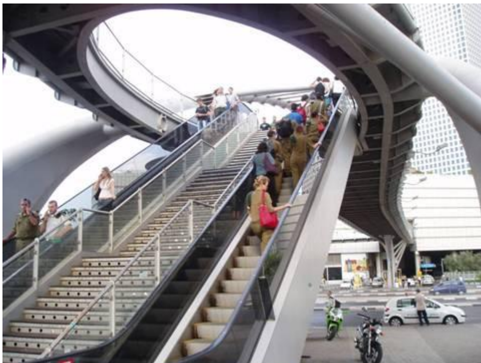
איור 49. מדרגות נעות בגשר להולכי רגל בדרך בגין בתל אביב
