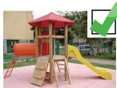
מתקן משחק מתאים לדרישות ת"י 1498. הוצב על משטח סופג אנרגיה, התקנתו בהתאם לדרישות התקן נבחנה ואושרה
