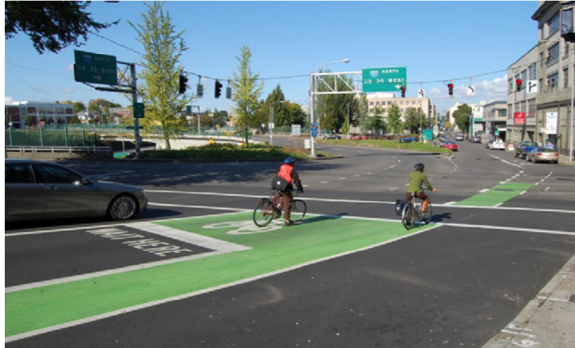
איור 1. תמונה של תיבת אופניים ירוקה בצומת מרומזר בפורטלנד, אורגון.
