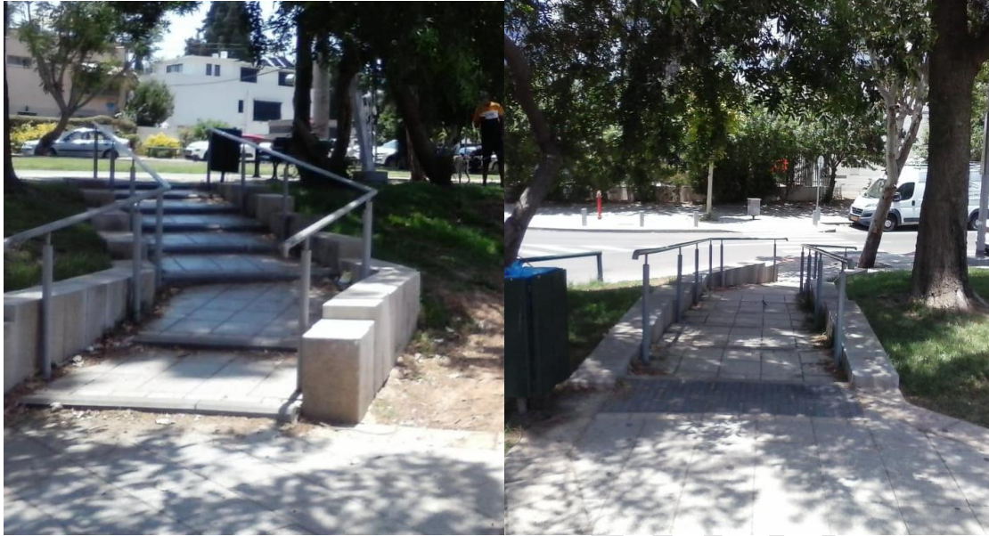
מדרגות מתונות ("מדרגות חמור") המאפשרות תנועת עגלות נוחה תוך התגברות על הפרש גבהים. רום כל מדרגה - 7 ס"מ. פארק שדרות ההשכלה בתל אביב יפו. תכנון וצילום: רם איזנברג עיצוב סביבה
