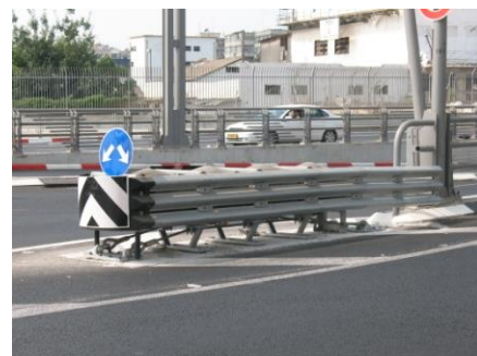
מעקה סופג אנרגיה שמותאם לדרכים עירוניות, שמותאם למהירויות של 50 עד 90 קמ"ש
